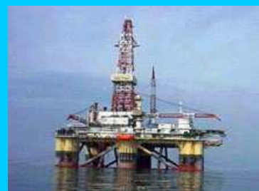
Plateforme de forage en mer
